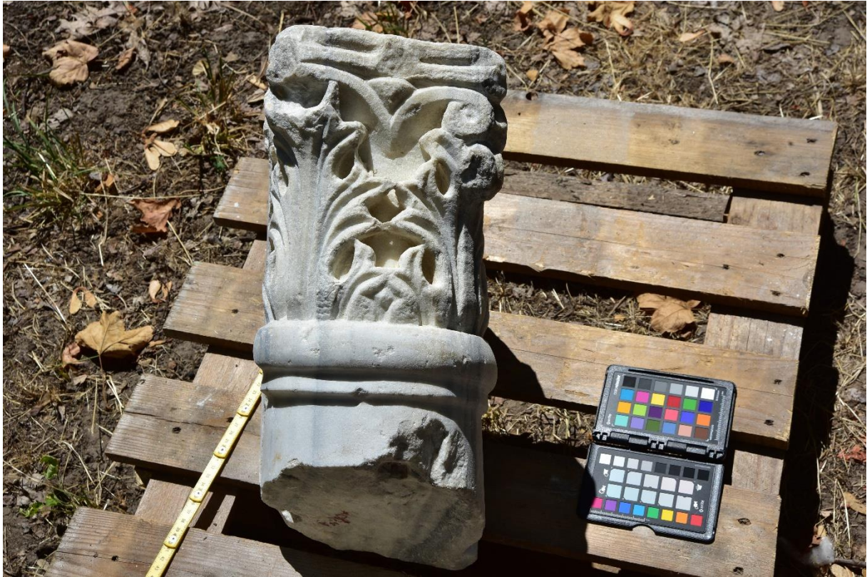
Fot. 16 Fragment kolumny wspierającej balkon ambony, stan po oczyszczeniu powierzchni. 2024
