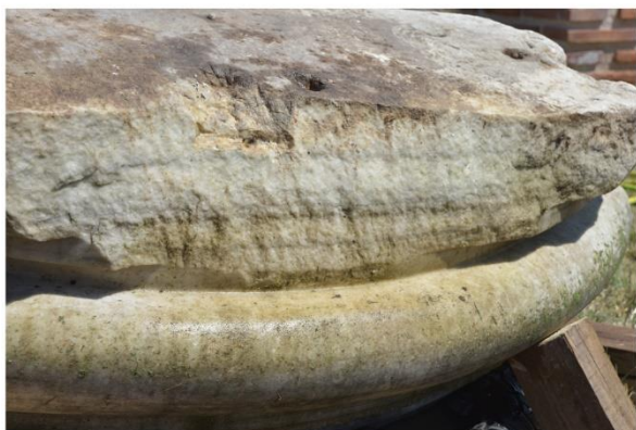
Fot. 39 – 44 Typy uszkodzeń oraz nawarstwień na powierzchni zachowanych elementów ambony. Stan na etapie prac konserwatorskich 2022.
