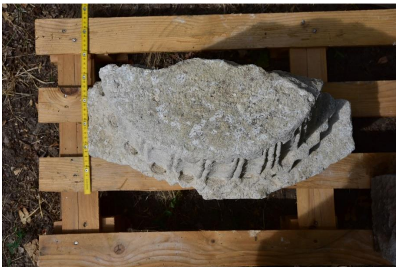
Fot. 10 ślad użycia dłuta płaskiego typu gradzina na spodniej powierzchni kapitelu
