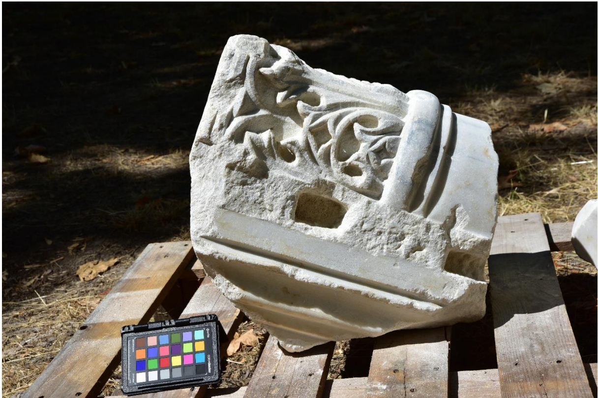
Fot. 17 Fragment kolumny wspierającej balkon ambony, stan po oczyszczeniu powierzchni. 2024
