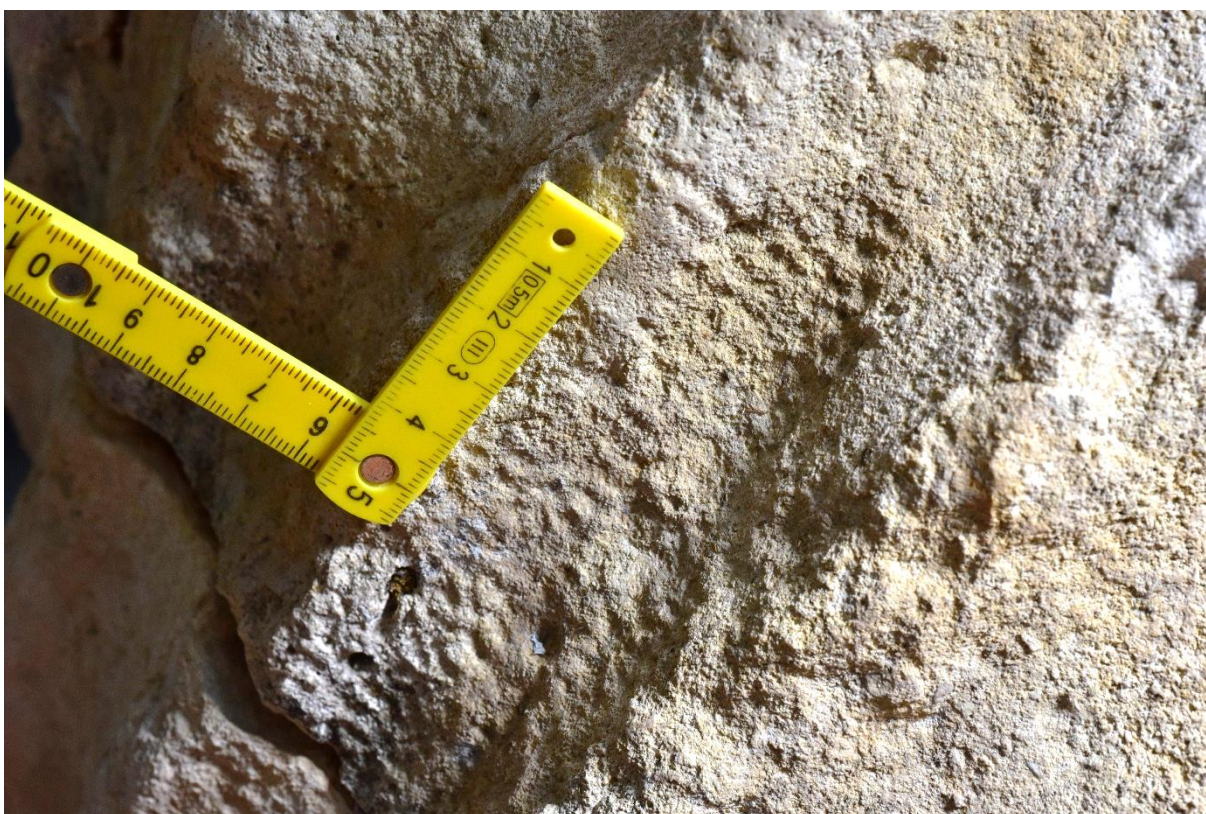
Fot. 29 Ślady użycia dłuta typu gradzina do wykonania ornamentu - kanelownie
