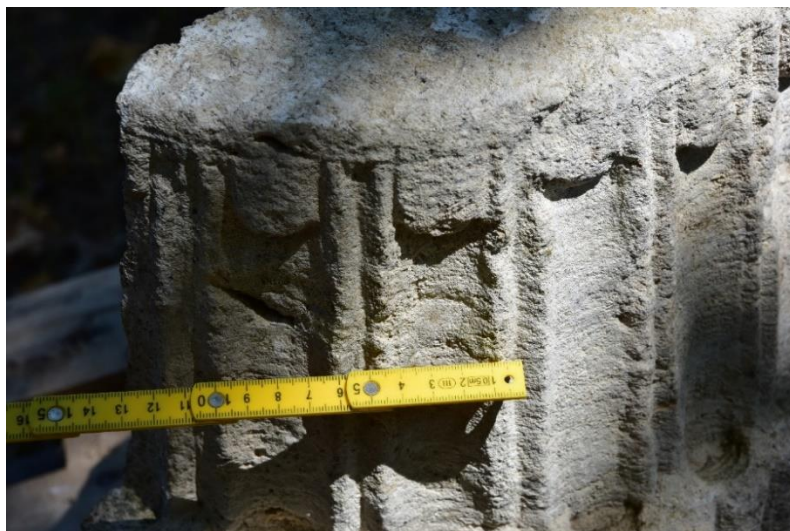
Fot. 5 Kapitel wapienny – czytelne ślady narzędzi kamieniarskich – narysy, dłuta
