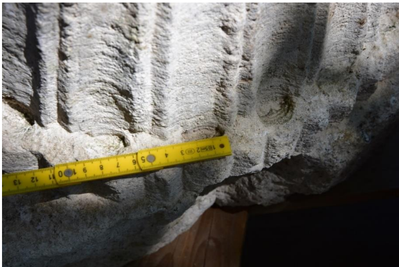
Fot.9 Ślady dłuta płaskiego do wykonania zagłębień na styku kanelowania i fryzu pod abakusem
