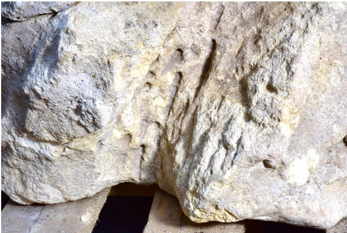
Fot. 30 Ślady użycia dłuta płaskiego do wydrążenia kanału wewnątrz kolumny
