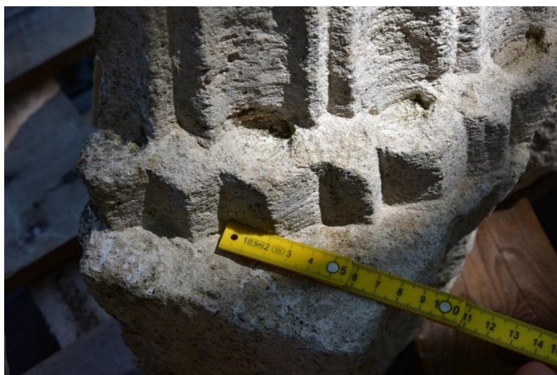
Fot. 8 Ślady użycia dłuta płaskiego do wykonania fryzu pod abakusem
