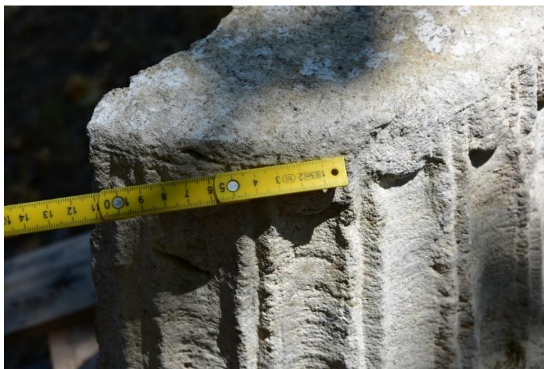
Fot. 6 Ślady użycia dłut płaskich do wykonania kanelowania
