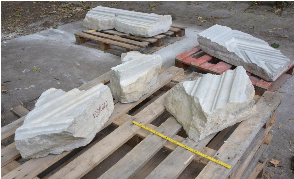
Fot. 22. Fragmenty oprawy schodów ambony, stan po pracach 2023
